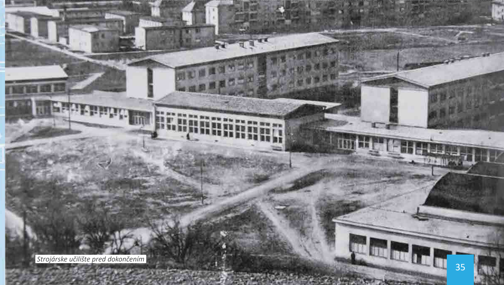
Slávnosť položenia základného kameňa strojárneho učilišťa
