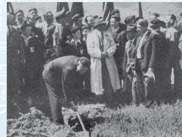
Vedúci učňovského strediska Jozef Štens pri slávnostnom výkope základov OU
